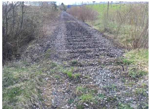
Abb. 13: Schotterkörper der zurückgebauten Gleisanlagen
