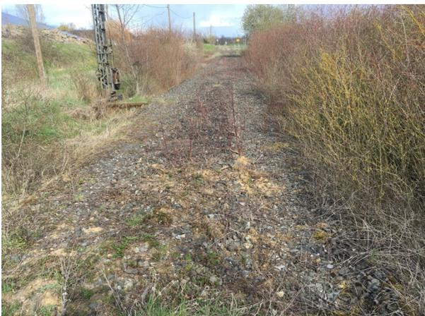
Abb. 12: Schotterkörper der zurückgebauten Gleisanlagen
